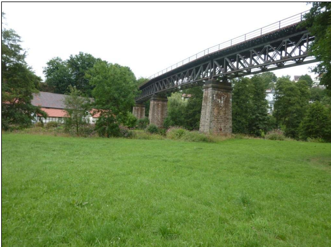
Ohmviadukt bei Homberg / Ohm
